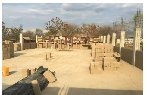
Hier entstehen der Aufenthaltsraum und die Bibliothek
